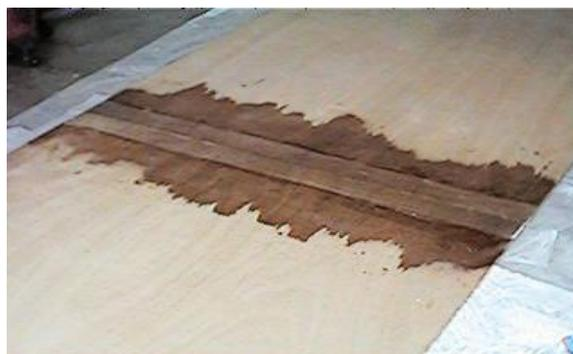
Рис.6. Стыковка с помощью стеклоткани
